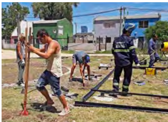
La comunidad construyendo su plaza.
