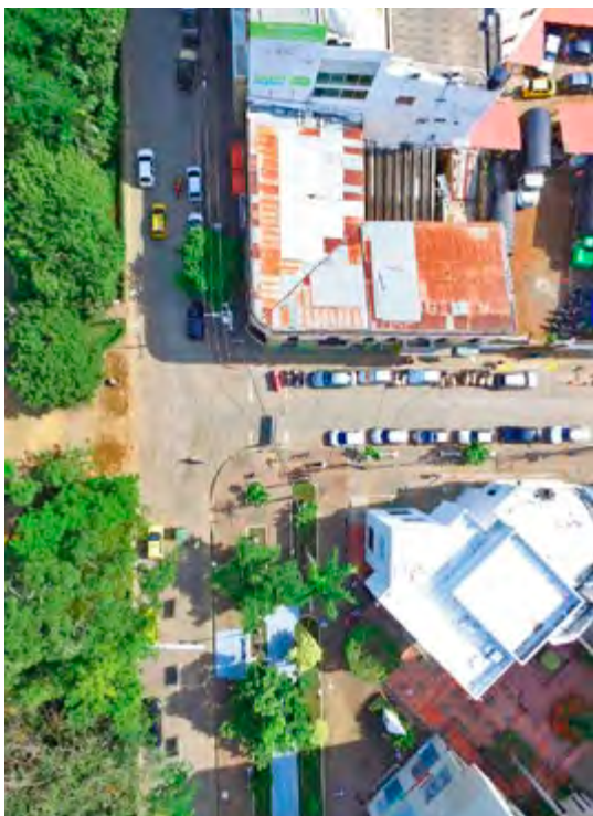
Antes y después de la intervención.
