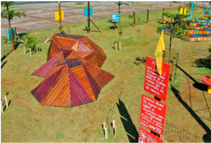
Rematéria: Mobiliario urbano con función de permanencia, fabricado en estructura metálica y revestido con madera. Foto: George Simas
