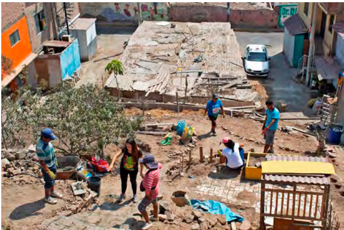
Proceso de construcción comunitario en Alto Perú, Chorrillos.
