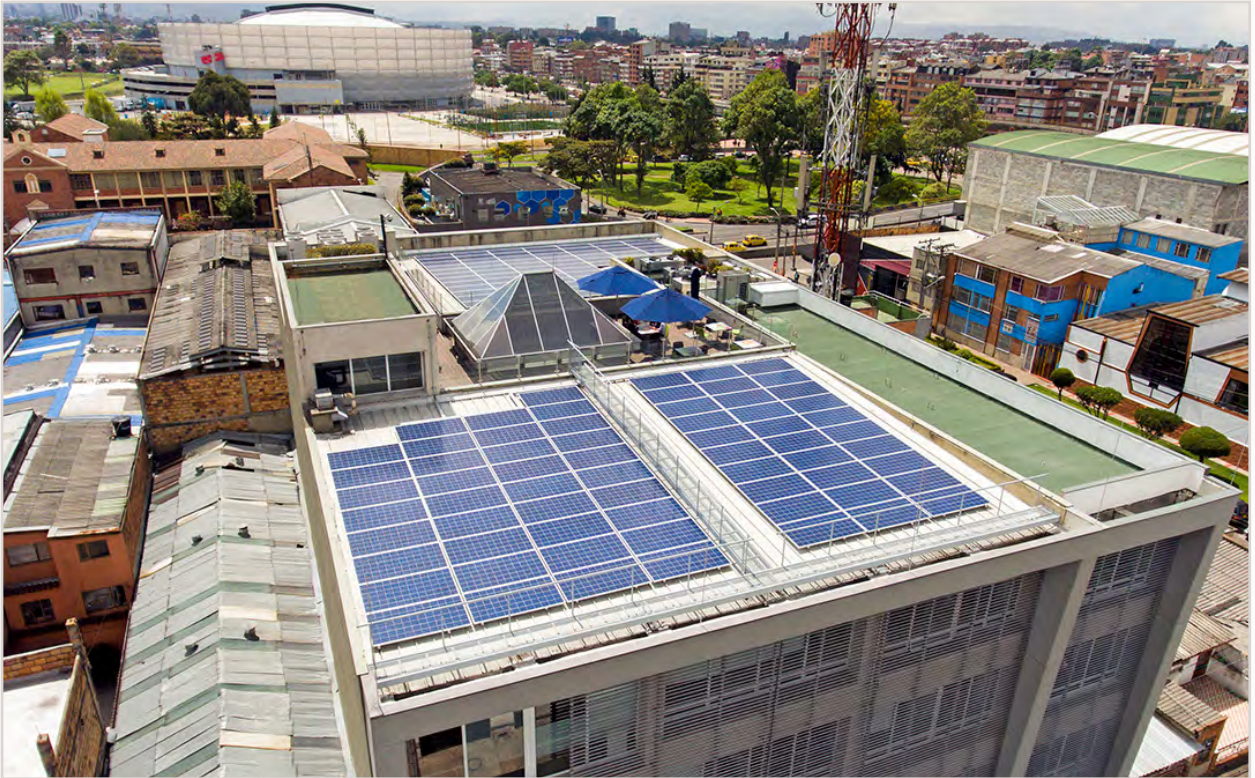
Paneles solares de Colmédica
