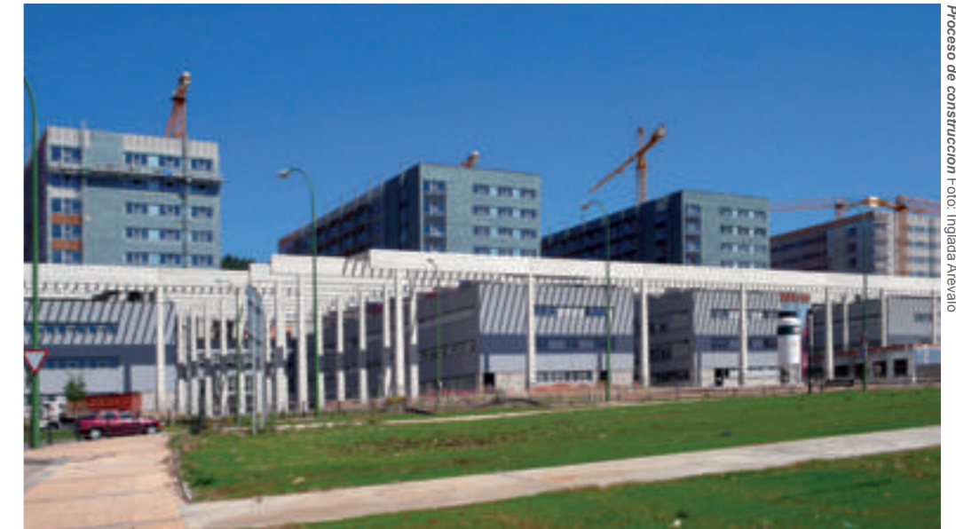
Proceso de construcción Foto: Inglada Arévalo
