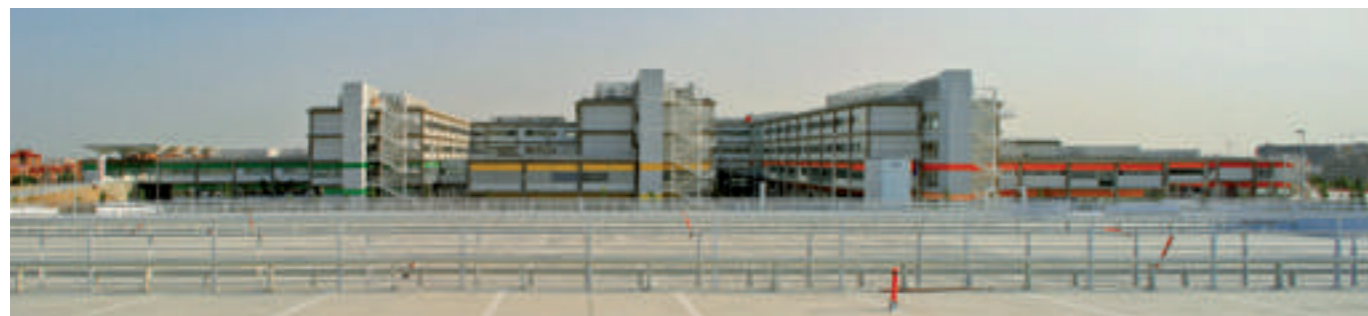
Vista del sistema de peaje. Foto: Vidal y Asociados
