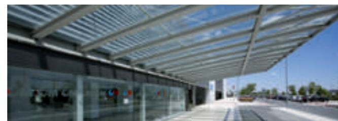
Detalle del acceso principal. Foto: Aidhos
